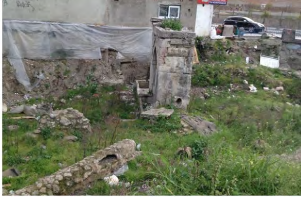
10. 2014 yılında çeşme ve çevresinin görünümü (Çeşme etrafındaki dolgunun kaldırılması sonucu çeşme bileşenleri ve çeşmeye ait temiz su tesisatı ortaya çıkarılmıştır)
