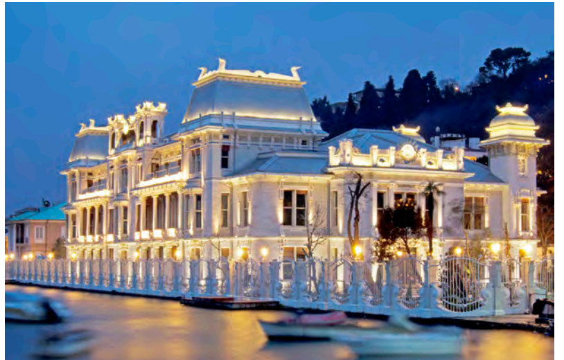
2. Yapının kuzeyden görünüşü
