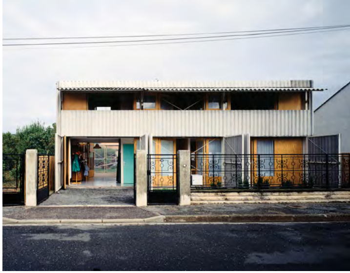
7. Latapie Evi, cadde cephesi
